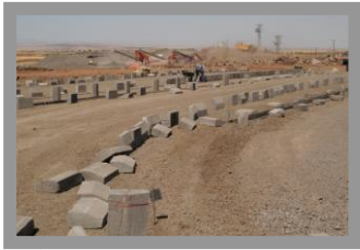
TDİOSB Alt Yapı Çalışmaları
